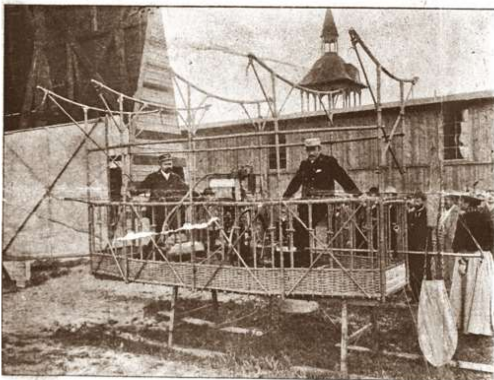
Die Gondel mit der Maschine.
